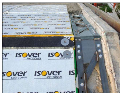
TC22 Esempio applicativo della giunzione colmo
